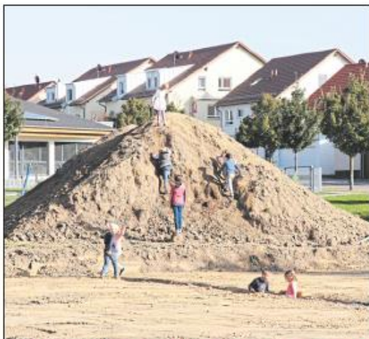
Für die jüngsten Gäste der Spatenstich-Hocketse war bereits der Baustellenaushub ein echtes Erlebnis.
